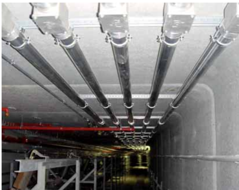
Galleria "Alti Fondali" - Savona
